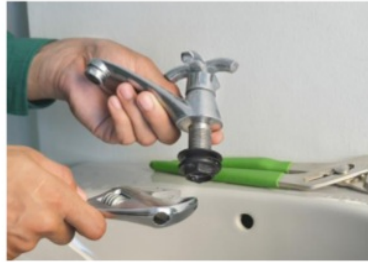
Gambar 13. 19 Memperbaiki Kran di Wastafel
